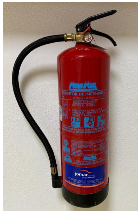
Exemple d'extintor tipus hídric mencionat
