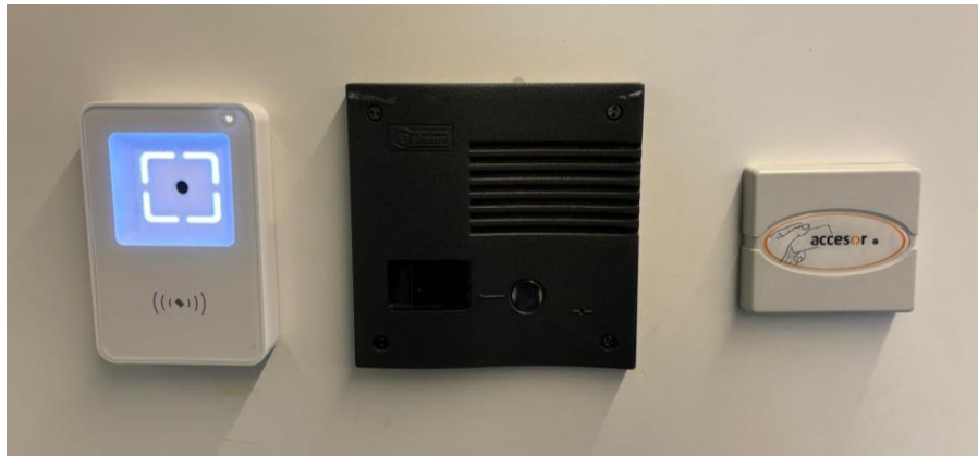
Exemple de col·locació de lector de proximitat, lector de codi QR i placa de carrer de kit videoporter d'accés a una ala d'hospitalització
