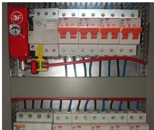
Model de referència sistema d'extinció automàtica d'incendis
